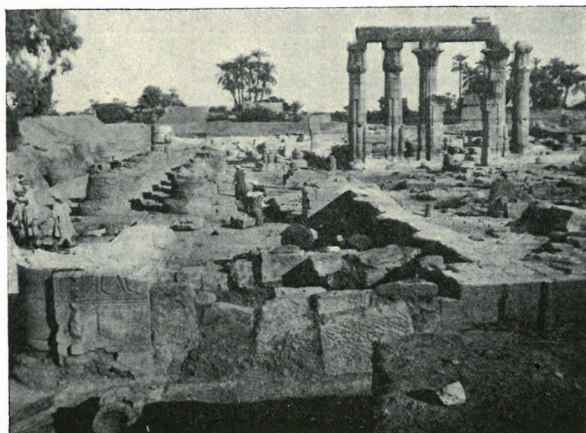
Fig. 31. — MURS COPTES DE LA PARTIE OUEST DU KIOSQUE NORD, VUS DE L'OUEST.
